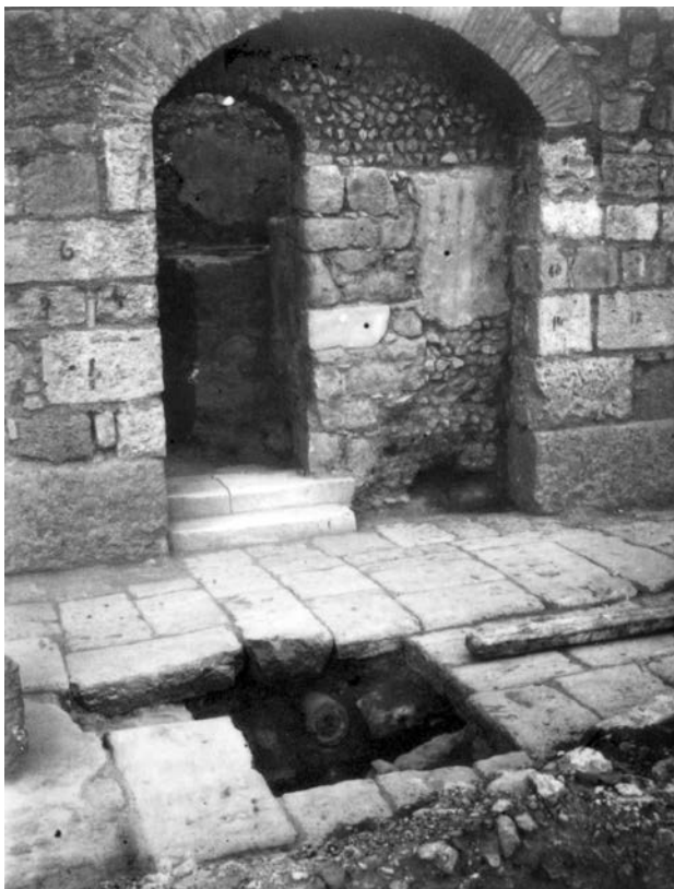
Fig. 37. Kos, latrina-ninfeo dei quartieri occidentali. Particolare dello scarico nel collettore fognario al di sotto del lastricato del cardo (Archivio SAIA, Fondo Morricone n. 960).
