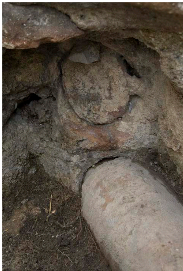
Fig. 13a,b. Kos, Terme Centrali: a) un castellum aquae addossato al paramento esterno del muro perimetrale ovest, pertinente ad una fase tardo-imperiale dell'impianto; b) particolare. Si noti, indicato anche a sinistra da una freccia rossa, il "tappo" di calce che ha chiuso la condotta, andata fuori uso (foto M.L. Masciopinto).
