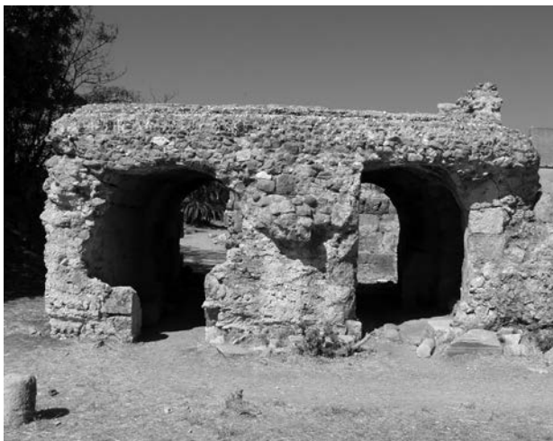
Fig. 25a,b. Kos, Terme Centrali: a) veduta da Est del serbatoio a Sud-Est del calidario meridionale; si notino i due vani voltati che lo sostruiscono; b) la pavimentazione a scaglie di marmo allettate nel coccipisto del serbatoio a Sud-Ovest del lo stesso calidario (foto G. Rocco).
