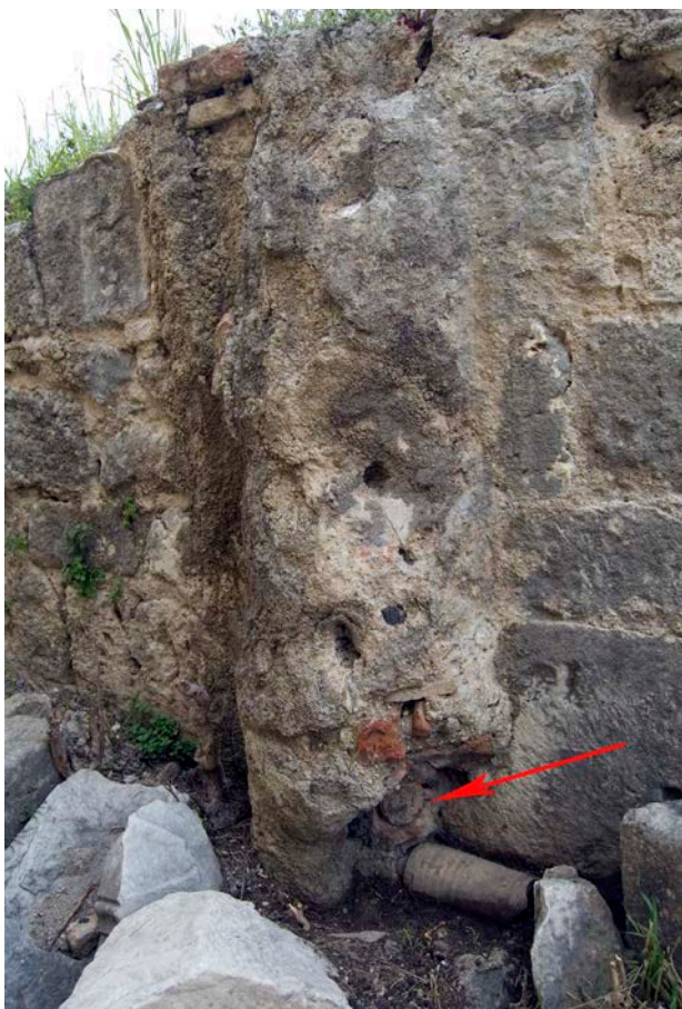
Fig. 13a,b. Kos, Terme Centrali: a) un castellum aquae addossato al paramento esterno del muro perimetrale ovest, pertinente ad una fase tardo-imperiale dell'impianto; b) particolare. Si noti, indicato anche a sinistra da una freccia rossa, il "tappo" di calce che ha chiuso la condotta, andata fuori uso (foto M.L. Masciopinto).
