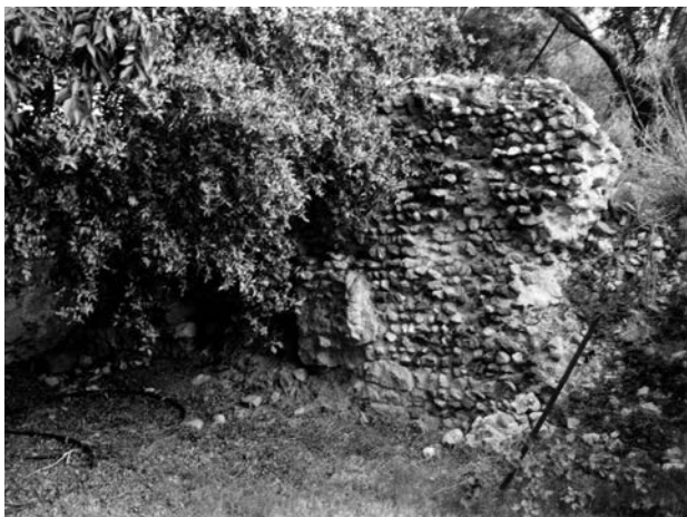
Fig.16a. Kos, area sud-occidentale. Resti delle strutture in opera cementizia pertinenti all'acquedotto di età imperiale (foto G. Rocco).
