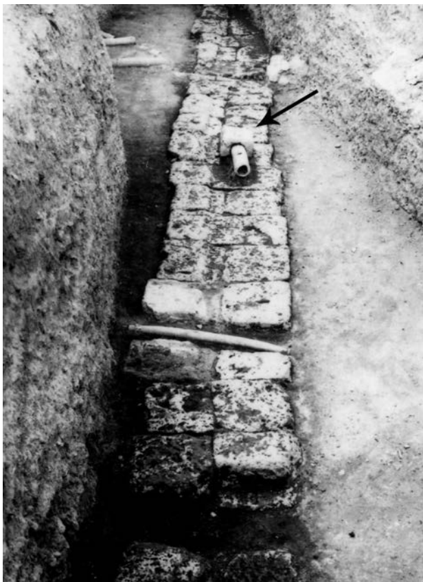
Fig. 8. Kos, Palestra del Ginnasio Occidentale, scavo Morricone 1938-40. La freccia indica un raccordo in pietra, con ancora un tratto di tubazione di terracotta inserita, posato sulla fondazione del muro di fondo del portico nord (Archivio SAIA, Fondo Morricone n. 519).
