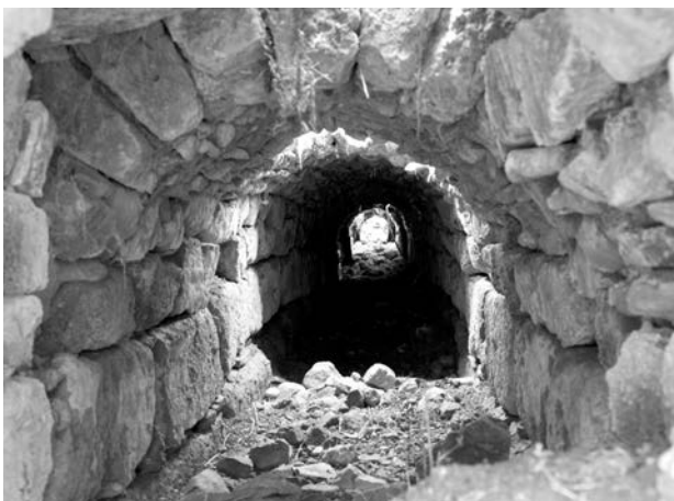
Fig. 36. Kos, canale fognario al di sotto della strada nord-sud tra l'isolato delle Terme Centrali e quello subito ad Est. L'immagine è presa allo sbocco sul canale principale raffigurato alle figg. 34, 35 (foto G. Rocco).
