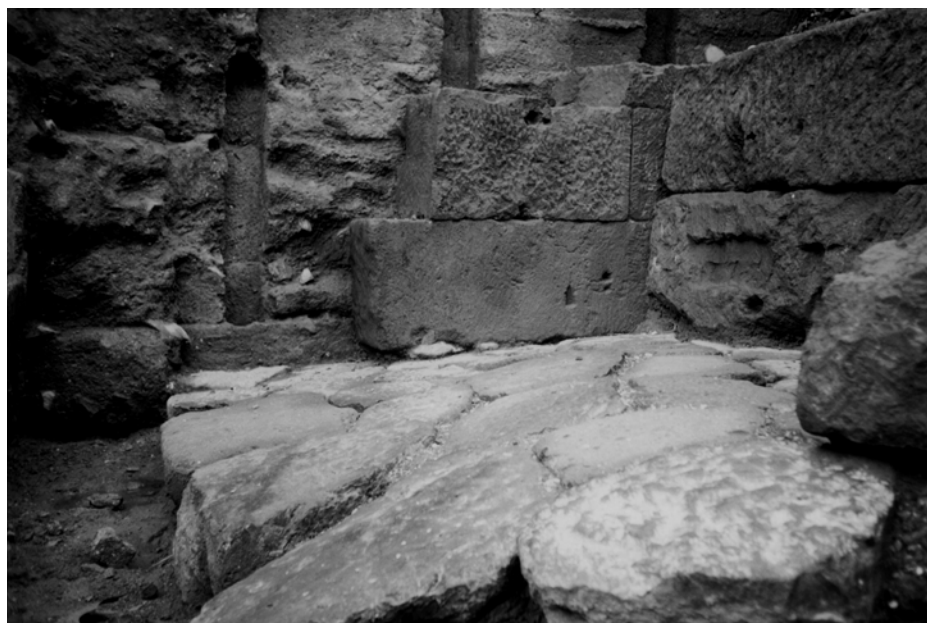
Fig. 12. Interno del compitum : si notino la pendenza della strada e il rinzeppo con pietre sotto i blocchi in opera quadrata per mantenere l'orizzontalità della piccola struttura.
