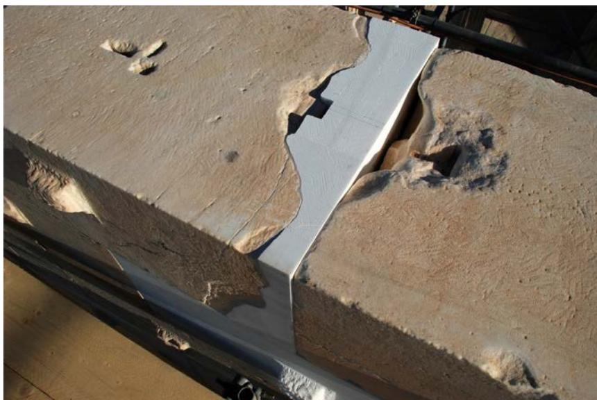
Fig. 24. Durante il trattamento con la gradina della superficie di una reintegrazione di uno dei blocchi della parte superiore del muro sud (dall'archivio YSMA).
