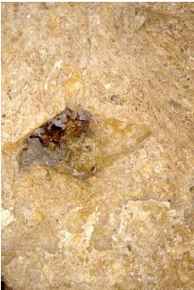
Fig. 18. Paestum, c.d. tempio di Nettuno, architrave, grumo di piombo, la lacuna antica scoperta durante la rifinitura in sito fu reintegrata con un tassello inserito a forza e fermato dal metallo duttile.
