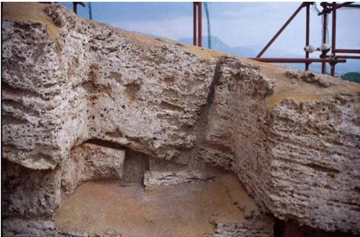
Fig. 24. Paestum, c.d. tempio di Nettuno, saggio di stucature sottosquadro, pigmentate e favorevoli al deflusso delle acque meteoriche.
