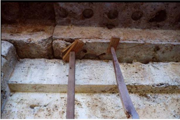
Fig. 21. Paestum, c.d. tempio di Nettuno, restauri ottocenteschi, cerchiature di architrave. E' stata ripristinata l'efficienza e sono state trattate con anticorrosivo.
