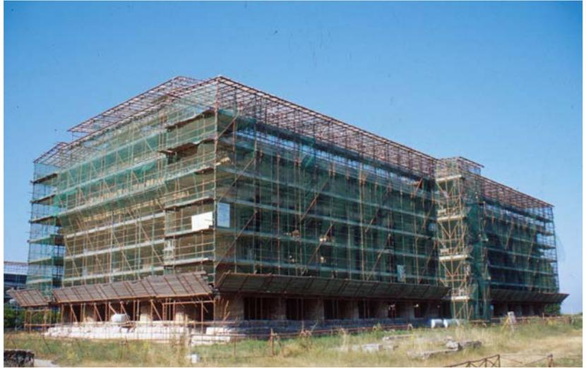
Fig. 29. Paestum, c.d. tempio di Nettuno, vista del ponteggio destinato ai visitatori del cantiere.
