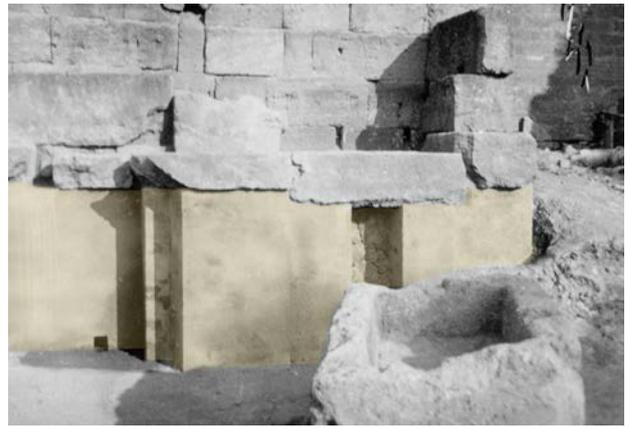
Fig. 23. Agrigento, fontana arcaica, 1932-1940. Consolidamento del terzo livello pavimentale del piazzale (da archivio BB.CC.AA Agrigento).
