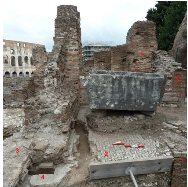
Fig. 27. Il solo grande blocco superstito della facciata severiana in opera isodoma, alla quale si addossavano i pilastri in laterizi (1). Il pavimento a grandi tessere (2) si riferisce alla fase tardoantica, alla quale appartengono anche le fondazioni del braccio sud del portico (3) e il tombino (4).
