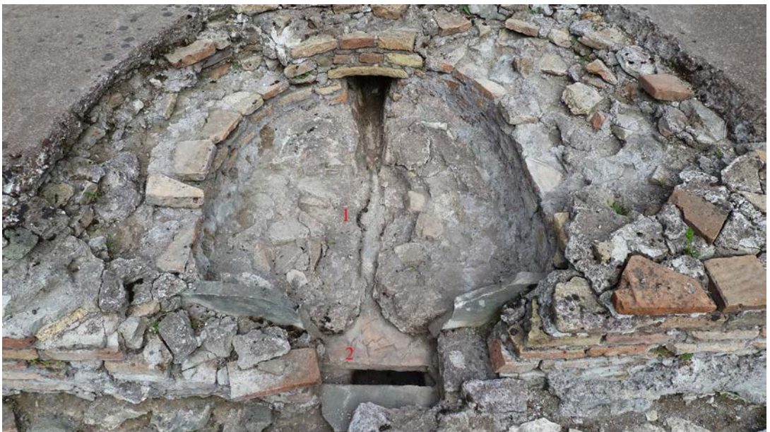
Fig. 54. Stibadium : particolare della vaschetta centrale con l'alloggiamento della fistula , il punto in cui era posto lo snodo verticale (1) e l'apertura per la fuoriuscita dell'acqua (2).
