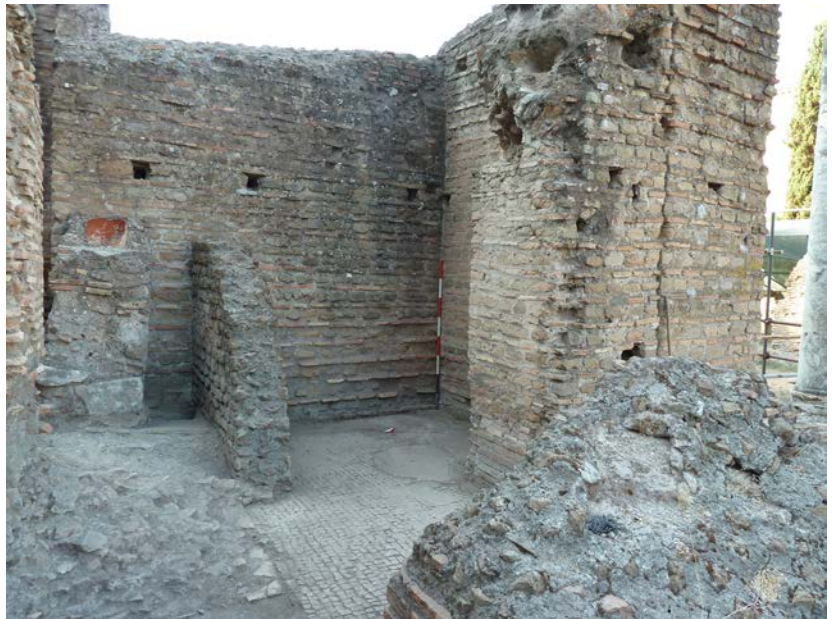
Fig. 35. Fase tardoantica: murature in opera vittata e pavimentazione a grandi tessere di marmo.
