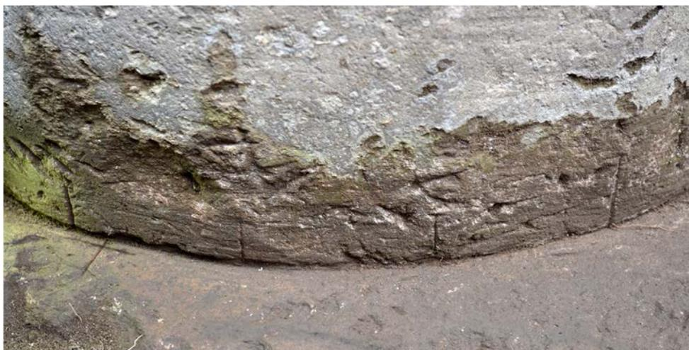
Fig. 16. Pompei, edificio ovest, particolare delle incisioni per la lavorazione delle scanalature e per il posizionamento delle colonne del portico di prima fase sullo stilobate (foto dell'A.).
