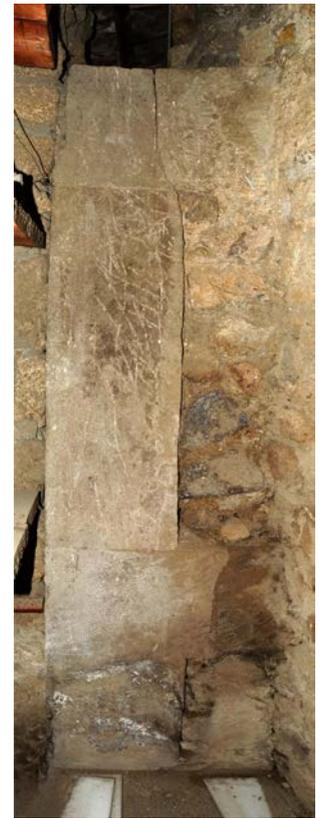
Fig. 6. Pompei, edificio ovest, particolare dell'anta occidentale del portico riutilizzata all'interno dalle strutture più tarde (foto dell'A.).
