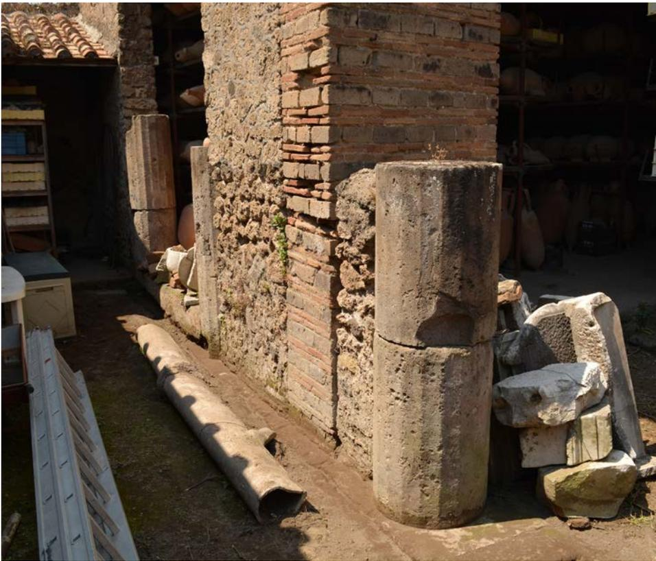
Fig. 5. Pompei, edificio ovest, particolare dei tre fusti inglobati nelle murature più tarde (foto dell'A.).
