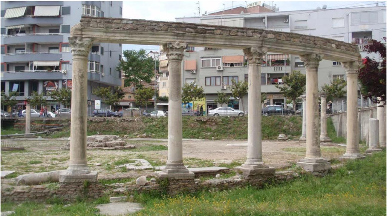
Fig. 14. *Macellum-forum*. Il settore nord-est del colonnato ricostruito nel 2003 con l'utilizzo di elementi originali e l'inserimento di una trabeazione in cemento armato (foto dell'A).
