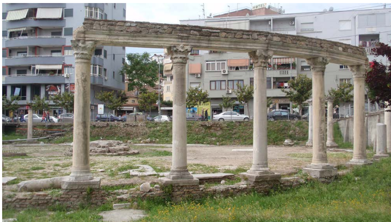
Fig. 14. Macellum-forum . Il settore nord-est del colonnato ricostruito nel 2003 con l'utilizzo di elementi originali e l'inserimento di una trabeazione in cemento armato (foto dell'A).
