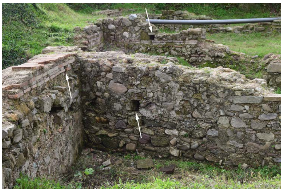
Fig. 10. Macellum-forum , vani VII e VIII. Alcune delle buche portaie visibili nelle fondazioni e nei muri di elevato.
