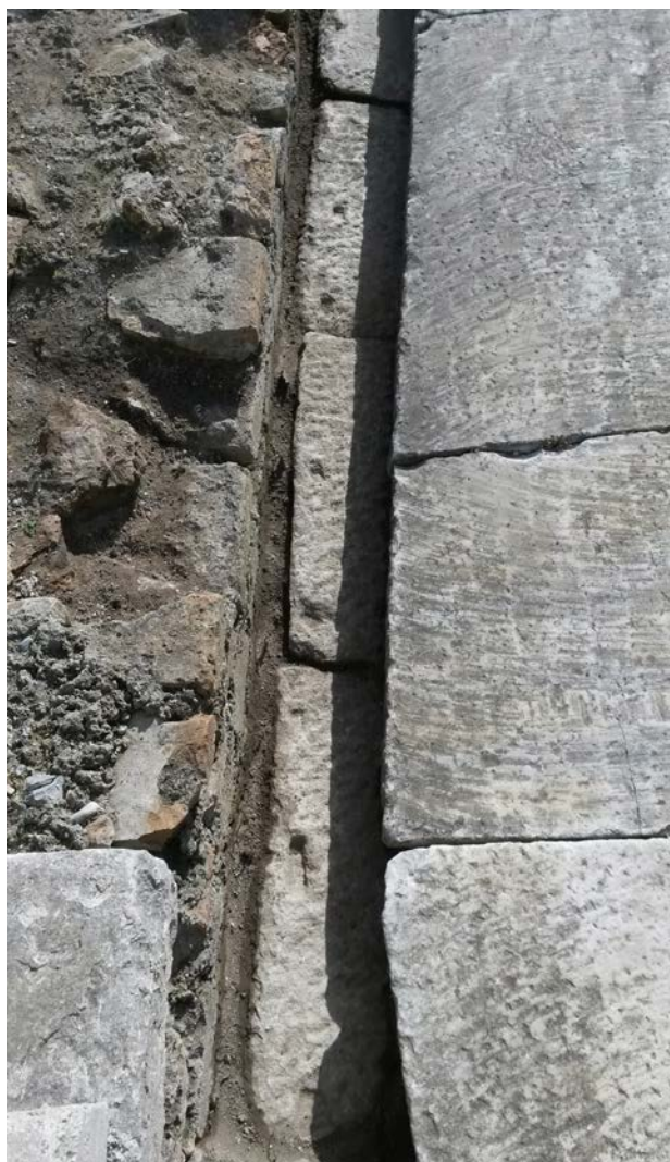
Fig. 21. Macellum-forum . La canaletta per il deflusso delle acque meteoriche tra lo stilobate circolare e la pavimentazione della piazza (foto dell'A).
