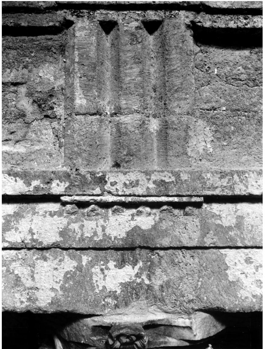
Fig. 24. Spoleto, basilica di San Salvatore. PS 4 triglifo, la parte inferiore è compresa nel pulvino.
