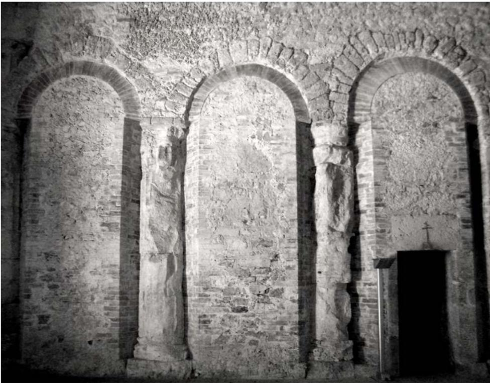
Fig. 6. Spoleto, basilica di San Salvatore. Navata centrale, lato nord: le colonne NS 8 e NS 9 inglobate nella muratura moderna di sostegno della parete.
