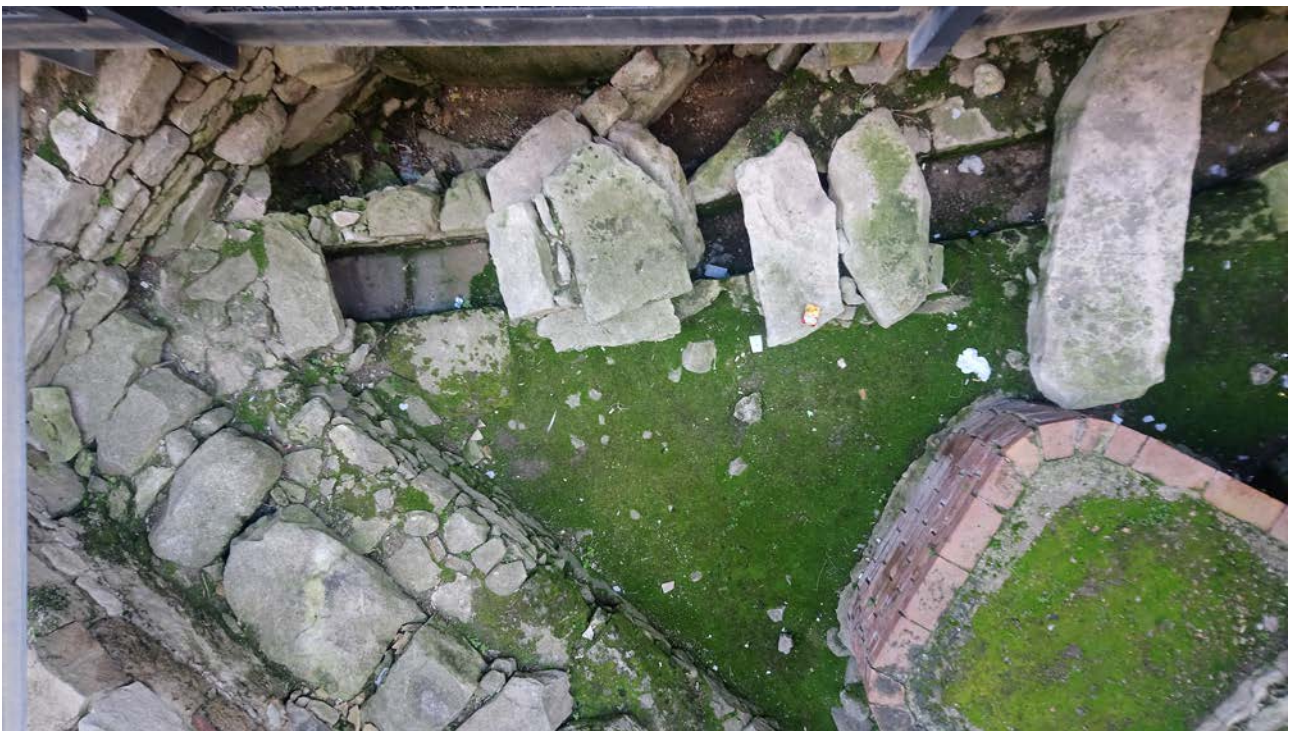
Fig. 13. Canaletta n. 11 con, al centro, confluenza della canaletta G, da Nord dall'alto (foto dell'A.).
