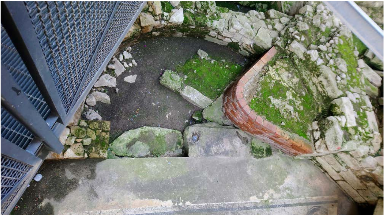
Fig. 9. Presunta soglia al centro del lato sud del vano E, da Nord; a destra, testimone con resti del pavimento in opus sectile relativo alla seconda fase (foto dell'A.).
