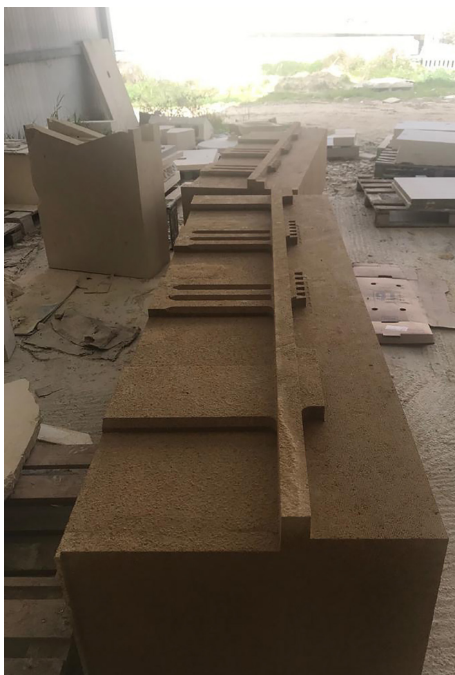
Fig. 19. Agrigento, complesso del santuario romano: ipotesi di anastilosi parziale. Ricostruzione di una cornice del muro nord in scala 1:1, sulla base dei rilievi 3D (realizzato da Pi.mar. srl).
