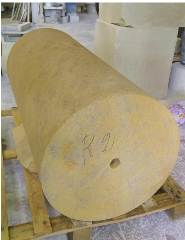
Fig. 17. Agrigento, complesso del santuario romano: ipotesi di anastilosi parziale. Ricostruzione di un rocchio di colonna in scala 1:1, sulla base dei rilievi 3D (realizzato da Pi.mar. srl).
