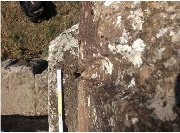
Fig. 6. Base dello *specus* dall'alto. Particolare dell'assisa inferiore, che si arresta in corrispondenza di una linea di fede e di un incasso per leva (foto dell'A., 2019).
