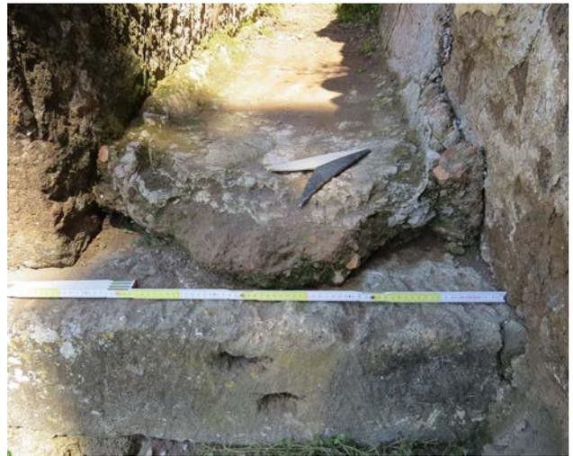
Fig. 5. Base dello *specus* visto da Sud-Est. Rivestimenti del condotto in cocciopesto (“barriera a”). Deposito calcareo al di sopra, con ghiaia “fossilizzata” (foto dell’A., 2019).
