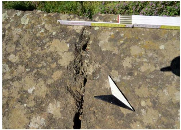
Fig. 7. Riempitura in cocciopesto di uno degli incavi (dall'alto), collocato a cavallo di due conci dello *specus*. *In situ* presso la parete sinistra, terzo filare (foto dell'A., 2019).
