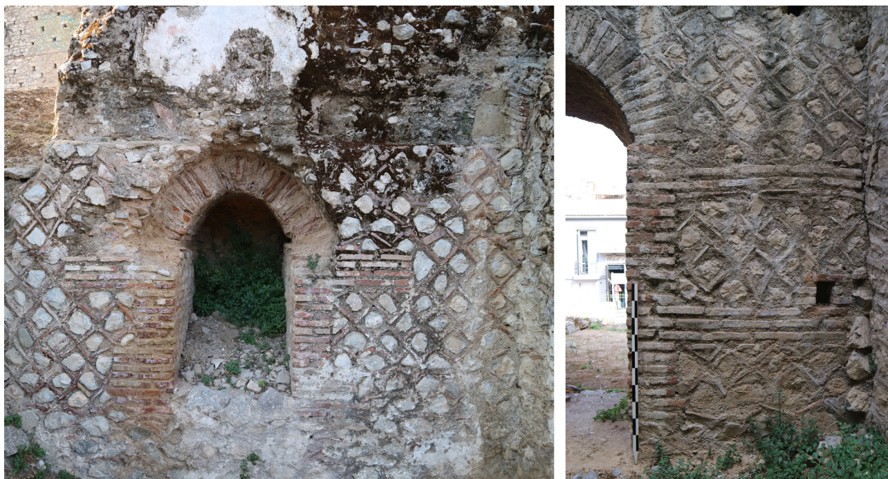
Fig. 19. Ambiente B' (a destra) e ambiente G (a sinistra): confronto tra le murature in Brick/stone opus reticulatum . Nella figura a destra si noti la differenza nella regolarità della maglia tra la parte inferiore e quella superiore.
