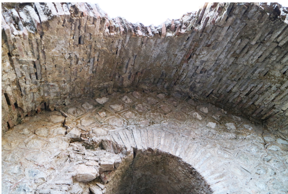
Fig. 23. Ambiente E, particolare della tessitura della volta in laterizio.
