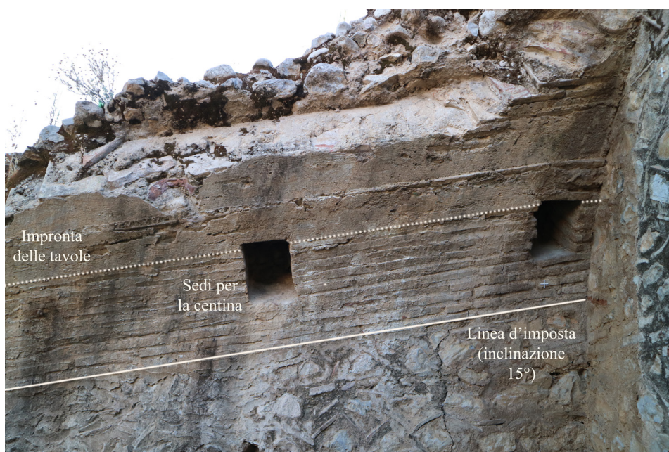
Fig. 24. Sistema di costruzione delle volte negli ambienti A-F.
