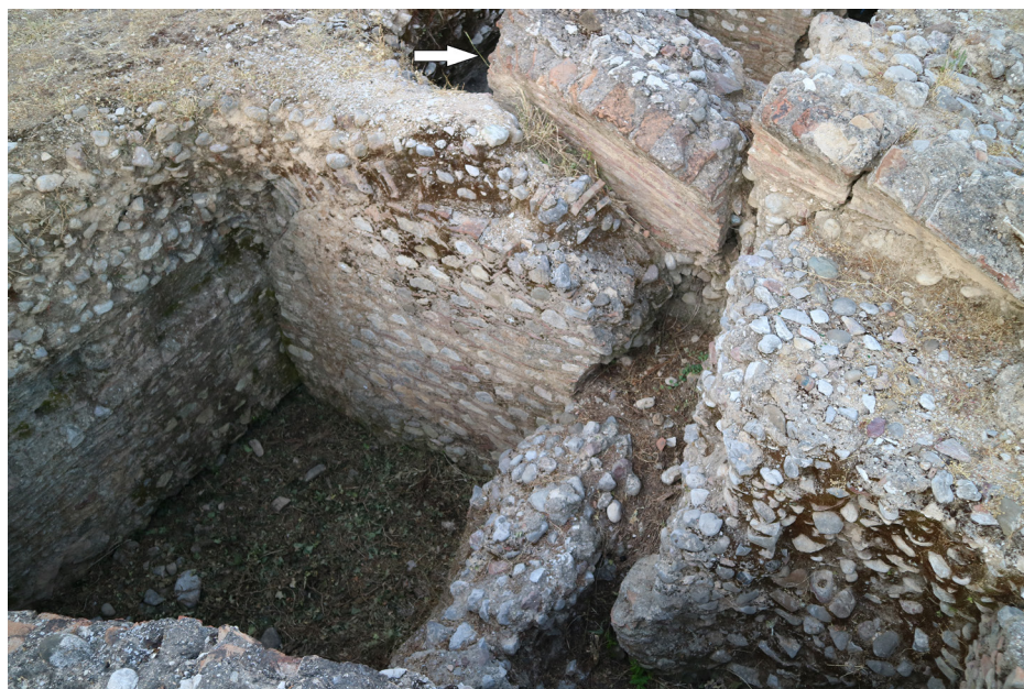
Fig. 12. Ambiente L, resti dell'ambiente e della volta posta sull'estradosso, ora in stato di crollo.
