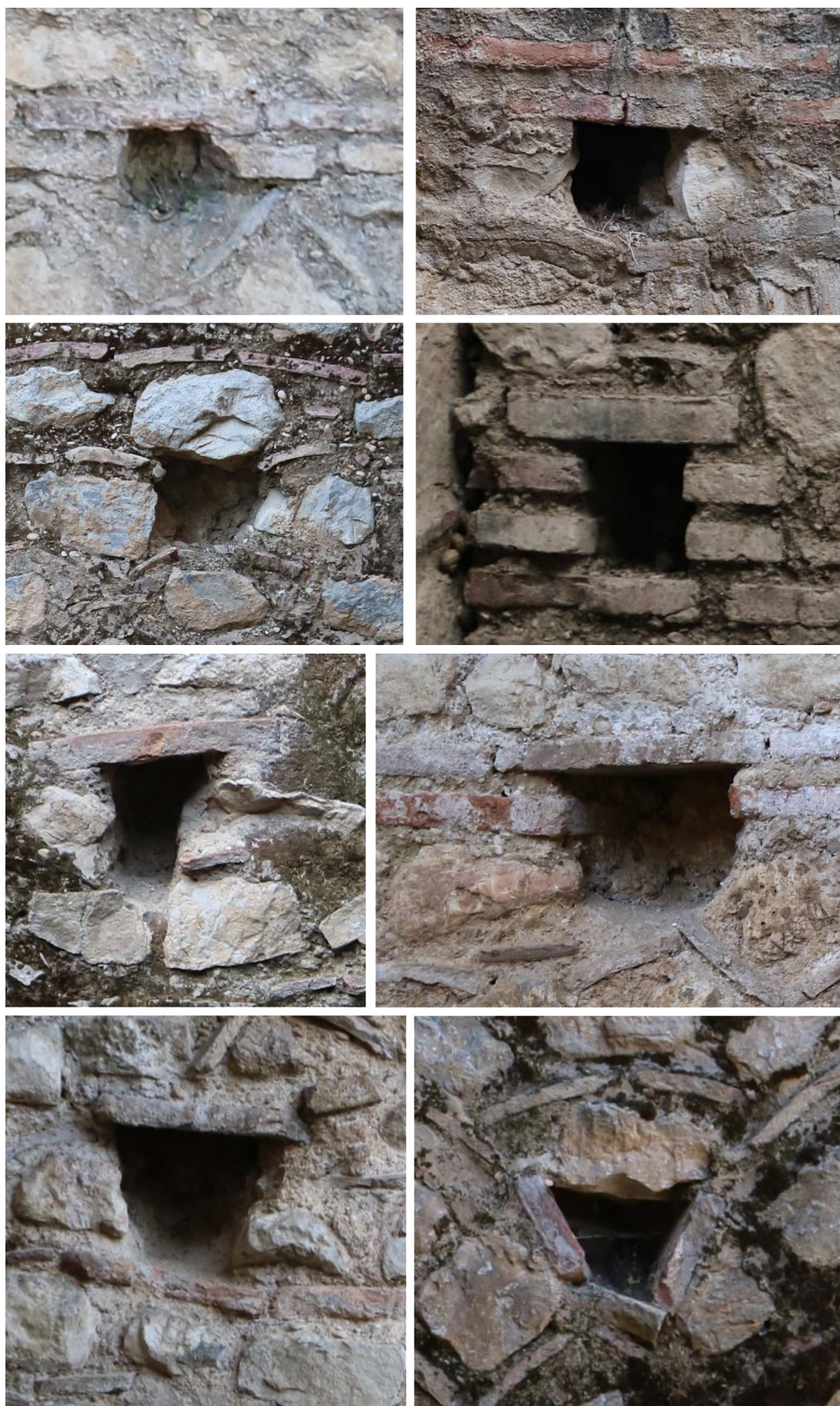
Fig. 32. Fori da ponte.
