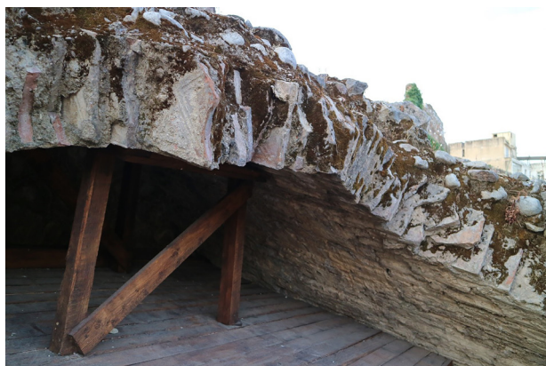
Fig. 15. Ambiente D, particolare dell'impiego di pedales interi nelle volte con impronta praticata con le dita lungo le diagonali.
