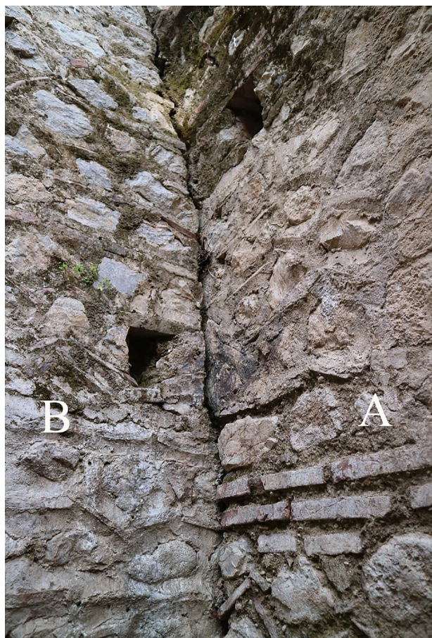
Fig. 35. Modalità di ammorsamento dei setti murari: nella parte bassa il muro A si appoggia al muro B, in quella superiore avviene il contrario.
