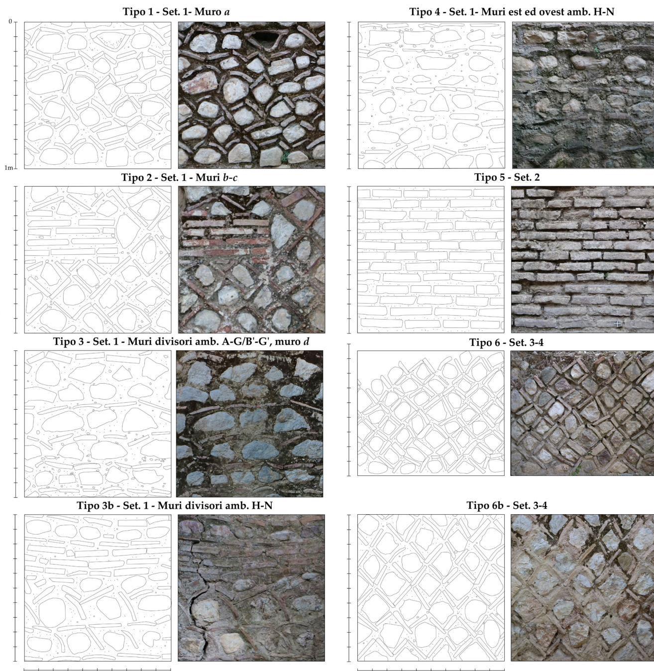
Fig. 18. Identificazione di differenti tipi di tecnica edilizia. Rilievo di dettaglio (rielab. da PETROPOULOS, PANSINI 2020).
