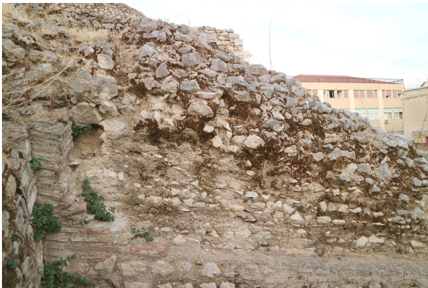
Fig. 29. Ambiente A, particolare delle differenti gettate di cementizio della volta. Le reni sono rinforzate scegliendo inerti di dimensioni maggiori.
