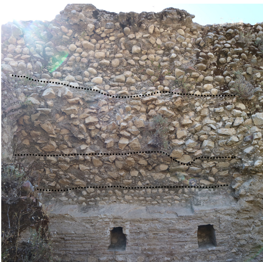
Fig. 30. Ambiente B', parete orientale, particolare della volta con manto intradossale in laterizio crollato. Dal basso verso l'alto si riconoscono: 1. una gettata con ciottoli di piccole dimensioni allettati su strati orizzontali; 2. una gettata con scapoli e scaglie di calcare di piccole e medie dimensioni; 3. una gettata con scapoli e scaglie di calcare di medie dimensioni affogate in malta di quantità non abbondante; 4. una gettata con ciottoli di medie e grandi dimensioni affogati in malta di quantità non abbondante.
