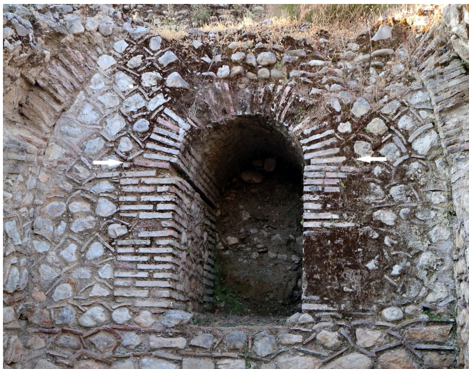
Fig. 28. Ambiente A, le frecce indicano gli incassi per il tavolato della centina.
