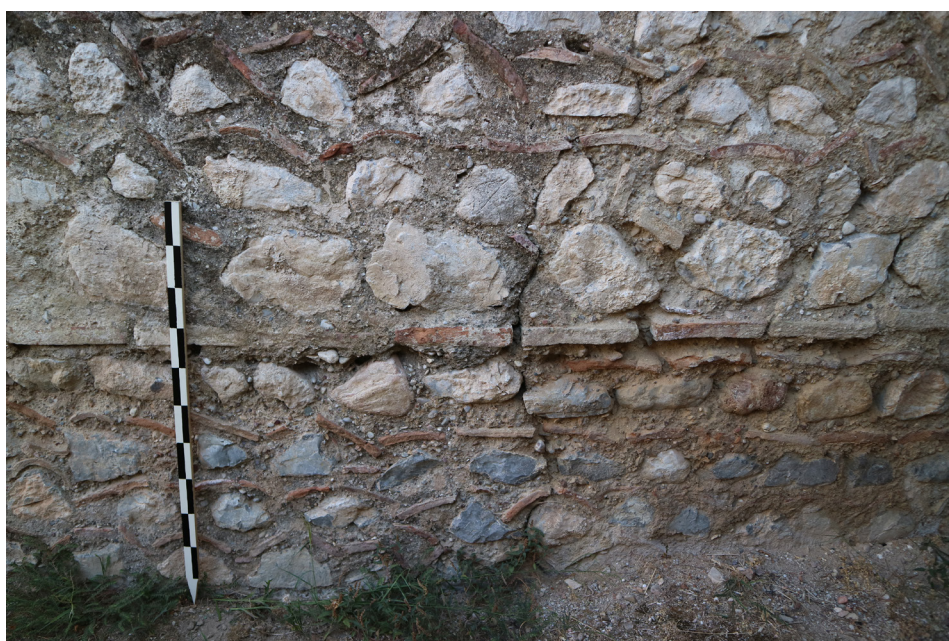
Fig. 21. Ambiente F, fondazioni costruite fuori terra in Brick/stone opus incertum .
