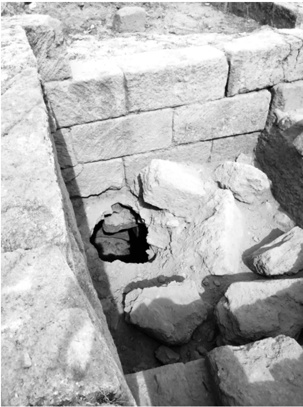
Fig. 22. Agrigento, area della fontana. Cavit  naturale che ha comportato un cedimento strutturale dei muri di terrazzamento soprastanti (foto G.M. Gerogiannis).
