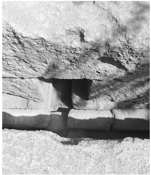
Fig. 12a,b. Agrigento, area della fontana. a. Dettaglio dei fori per la fuoriuscita d'acqua sulla fronte dell'edificio; b. varco di immissione realizzato assieme all'innalzamento delle spallette del canale (foto G.M. Gerogiannis).
