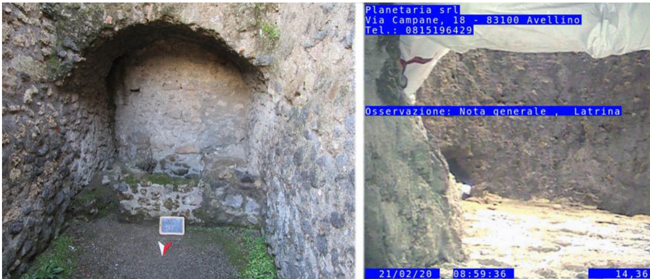
Fig. 4. La latrina 113 , il cui scarico è connesso direttamente alla cloaca sottostante tramite P3 . A sinistra la latrina vista dalla superficie (VIII.4.7); a destra la stessa latrina fotografata dall'interno del collettore fognario dal robot teleguidato ipek rovion rx 130.
