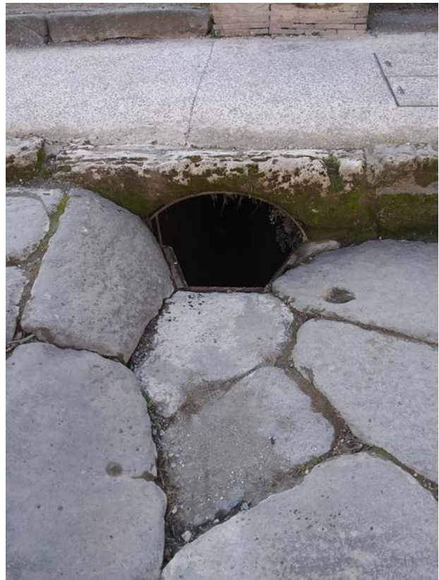
Fig. 8. L'inghiottitoio a Nord della cloaca aperto nella crepidine sud di via dell'Abbondanza (foto Autore).
