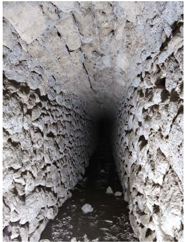
Fig. 11. Interno del collettore del tratto b (foto Autore).
