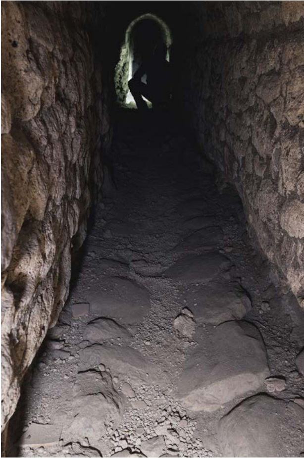
Fig. 12. Interno del collettore del tratto b . Resti della canalizzazione sul fondo del condotto (foto Autore).
