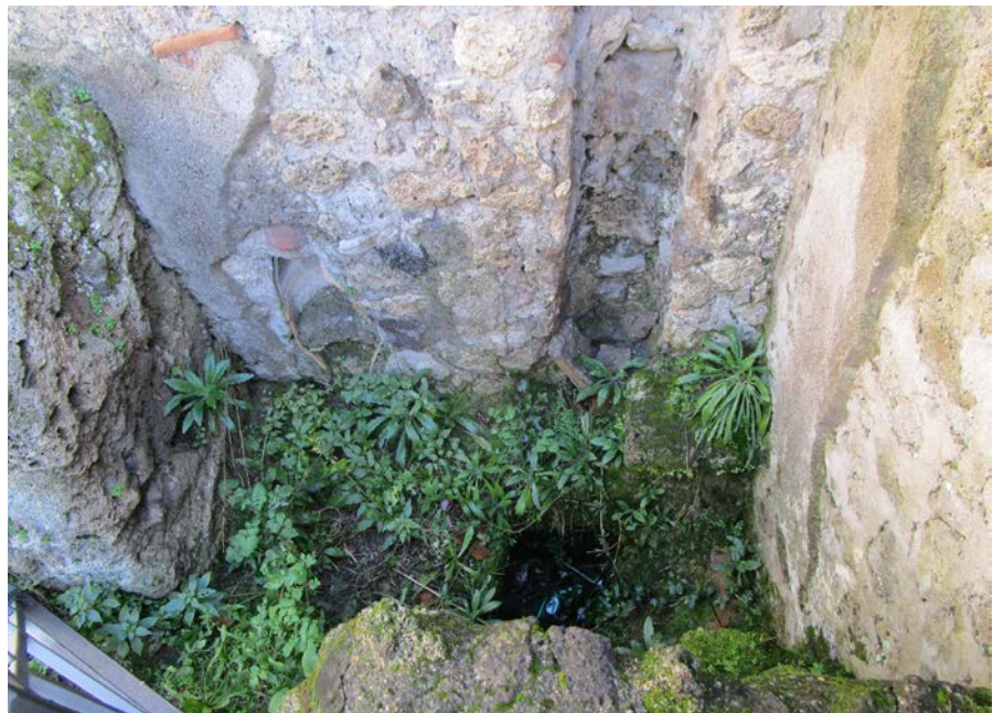
Fig. 6. Latrina e scarico provenienti dal secondo livello dell'edificio ( P6 = 101 ) (foto Autore).
