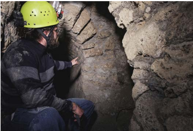
Fig. 14. In evidenza la breccia presente lungo il lato est del condotto causata dal cedimento delle strutture (foto A. Cimini).
