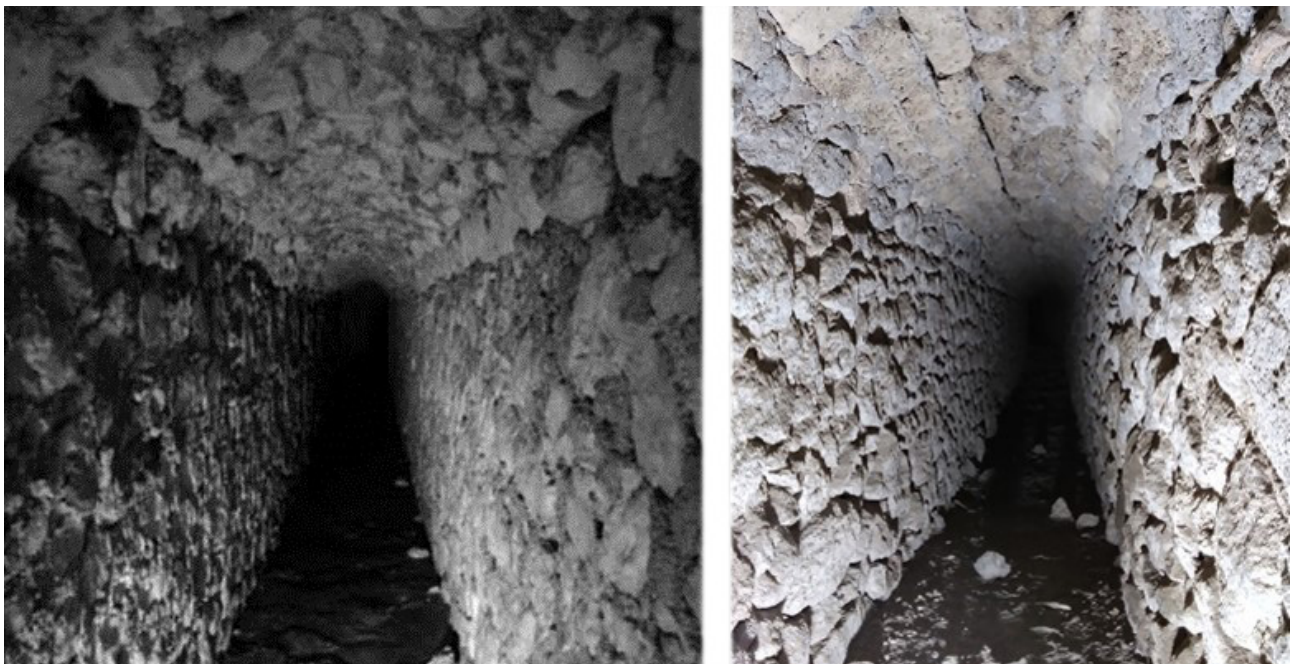
Fig. 25. A sinistra, interno del collettore fognario di Alba Fucens (da ROSE 2018, pp. 495-497); a destra, interno della cloaca della valle stabiana di Pompei (foto Autore).
