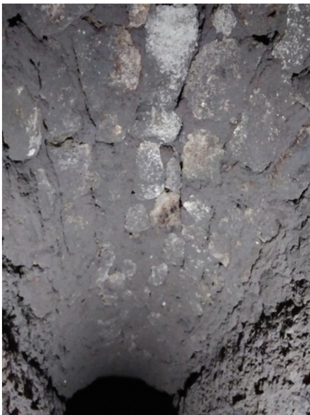
Fig. 22. Tratto c della cloaca: a sinistra la volta in conci di calcare del Sarno; a destra la sola porzione di volta realizzata in conci di spuma lavica (foto Autore).
