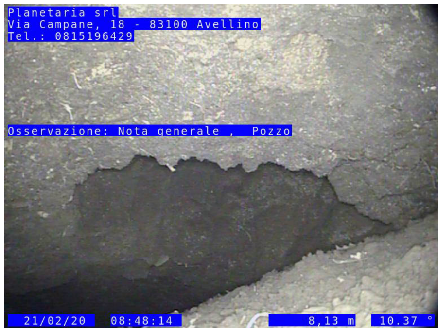
Fig. 4. La latrina 113 , il cui scarico è connesso direttamente alla cloaca sottostante tramite P3 . A sinistra la latrina vista dalla superficie (VIII.4.7); a destra la stessa latrina fotografata dall'interno del collettore fognario dal robot teleguidato ipek rovion rx 130.
