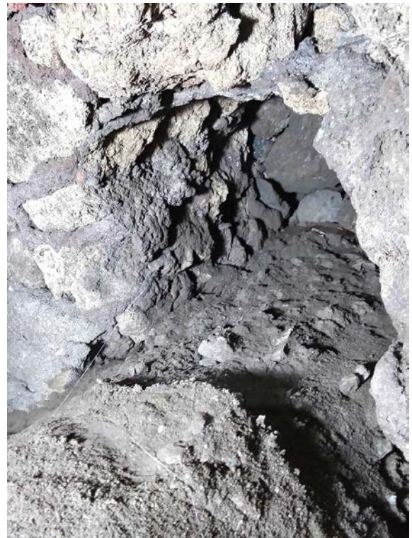
Fig. 14. In evidenza la breccia presente lungo il lato est del condotto causata dal cedimento delle strutture (foto A. Cimini).
