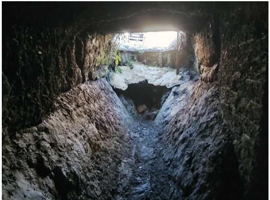
Fig. 1. La canalizzazione proveniente da Nord con l'apertura dell'inghiottitoio di via dell'Abbondanza visti dall'interno del collettore (foto Autore).
